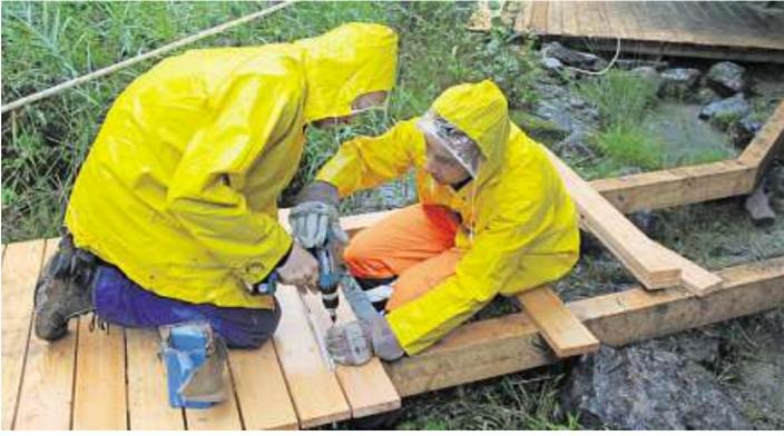
Bei strömendem Regen: Eine Zweiergruppe verschraubt die Querbalken des Stegs zur Plattform.
