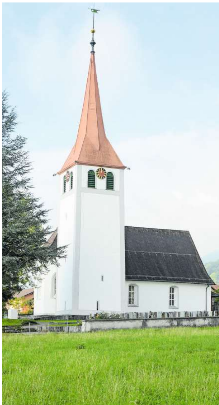
Das Feuchtigkeitsproblem in der Kirche Sax soll mit einer gründlichen Sanierung behoben werden.
