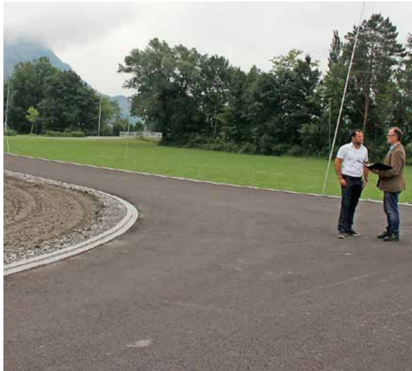
Die Schlussbesprechung bei der Abnahme der neuen Strasse: Projekt- und Bauleiter Dipl. Ing. Patrick Riedlechner zusammen mit Ortspräsident Heinz Lutz.
